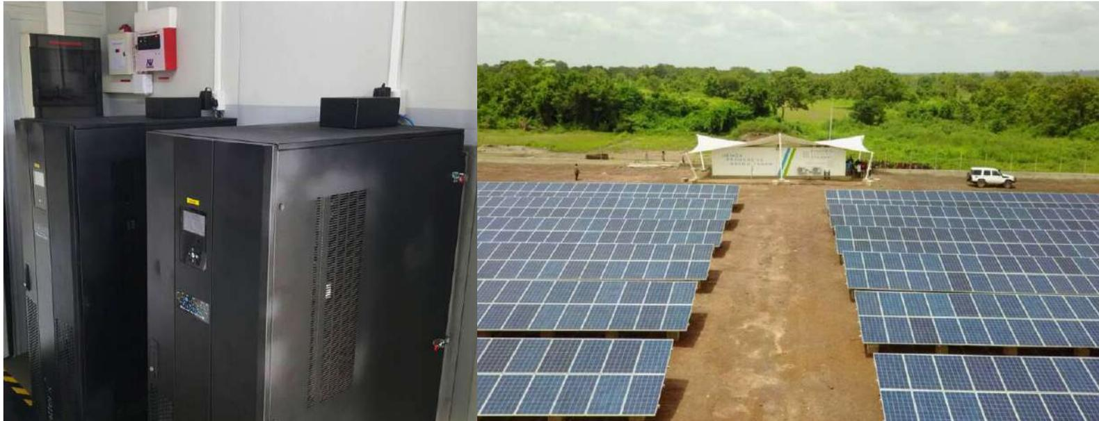
Realización de una planta de energía fotovoltaica en Togo en un sitio aislado de **320 kVA**, campo fotovoltaico de **156 kWp** y baterías de almacenamiento **OPzS** que proporcionan **1,5MWh**
